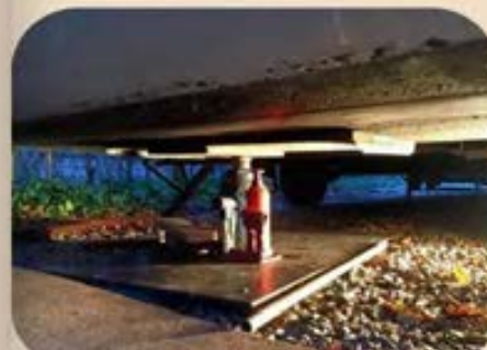
De onderkant moet in vorm worden gebracht d.m.v. autokrikken.
