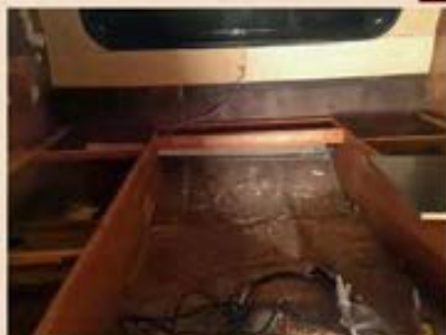
De triplex vloerplaat is gelegd.
