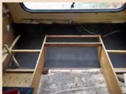
De triplex vloerplaat is gelegd.
